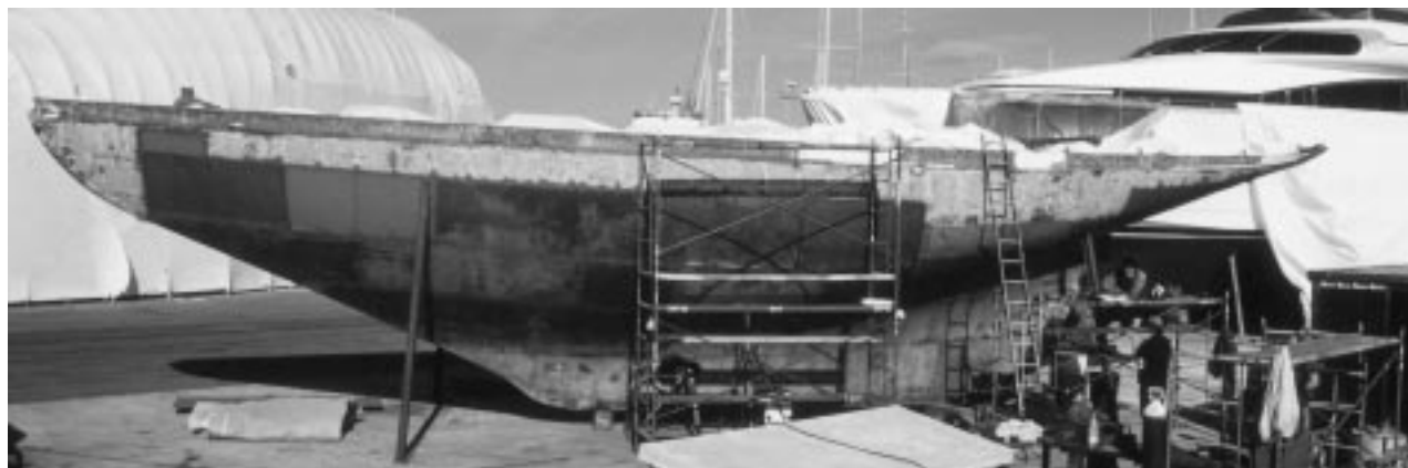
Talisman i december på varv. Med all ny plåt på plats kan man åter se hennes förföriska linjer.
