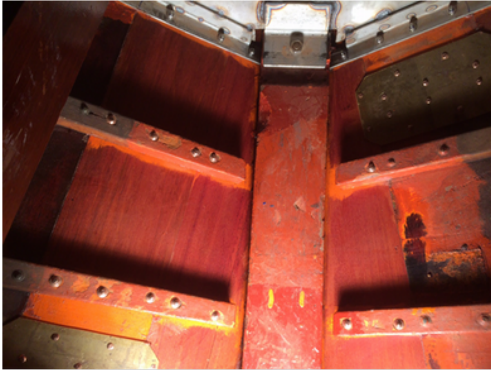
Slipning och oljning klart inifrån
