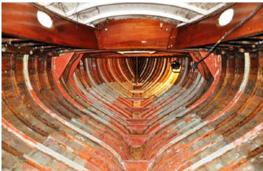
Skrovet invändigt tomt för renovering av spant och bottenstockar.
