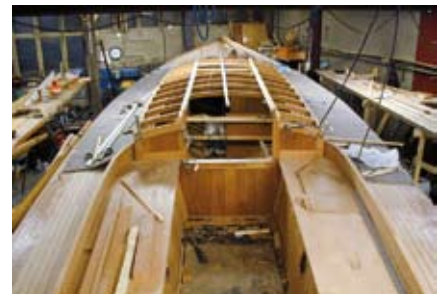
Nytt rufftak under konstruktion.
