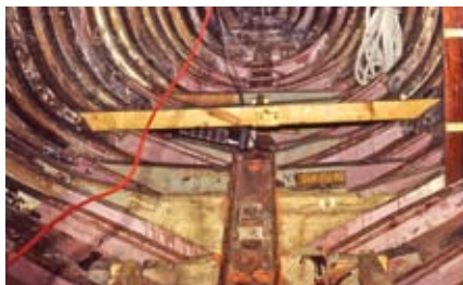
Spant och bottenstockar före renoveringen...
