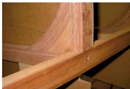
Balkvägare och ringspant.
